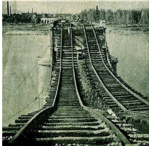
Arche détruite en 1944
