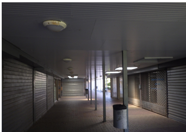
5 - La galerie intérieure
