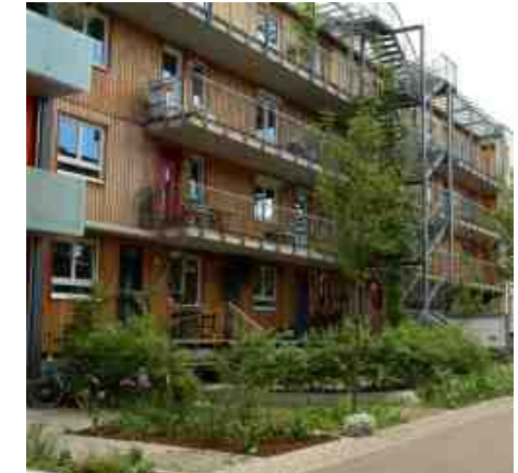
Exemple d'utilisation de l'eau de pluie récupérée en toiture
